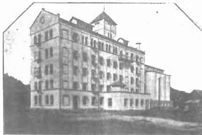
Fundos do prédio, vendo-se, em baixo, a rede dos motores electricos
